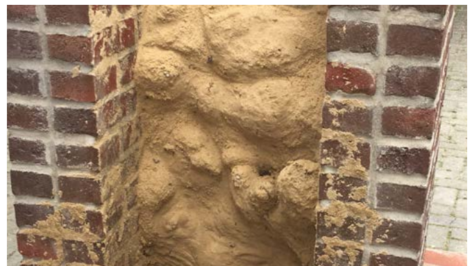
Scherminjectie (achterzijde aanzicht)
