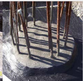
Aansluiting van de oppervlakteafdichting (KÖSTER Deuxan 2K-Spateldicht) op de afdichting van de paalkop
