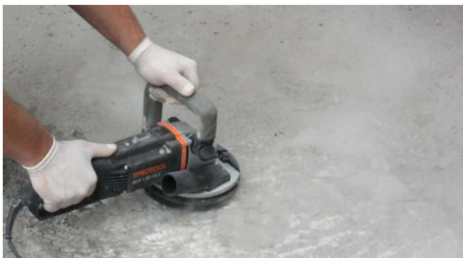
Ondergrondvoorbereiding
