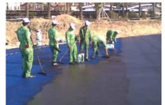
Afdichting met KÖSTER Deuxan 2K-Spateldicht
