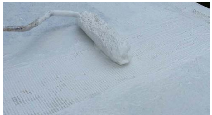
Eerste laag KÖSTER 21 met KÖSTER Flexweefsel
