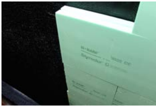
Met KÖSTER Deuxan 2K-Spateldicht kunnen isolatieplaten eenvoudig op de afdichting worden bevestigd. Het is belangrijk om het gehele oppervlak te verlijmen.
