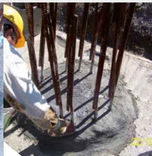
Afdichting van de paalkop met KÖSTER NB 1 grijs
