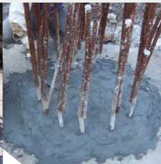
Vorbereiding van een kim en egalisatie van het oppervlak met KÖSTER WU-reparatiemortel
