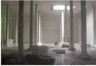
Positieve afdichting in een tank met KÖSTER NB 1 grijs
