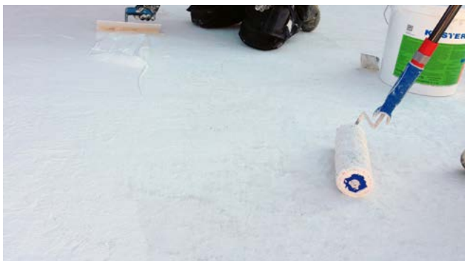
Opbrengen van 2e laag KÖSTER 21
