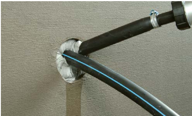
KÖSTER KB-Flex 200 wordt met het KÖSTER-handpistool in de opening gespoten.
