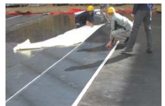
Afdichting met KÖSTER KSK
