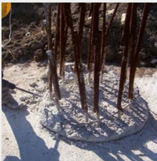
Overtollig beton verwijderen en het oppervlak reinigen
