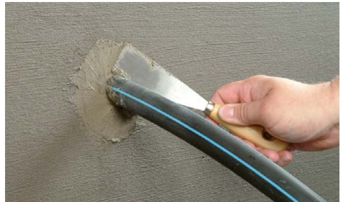
Om de waterdichtheid te beschermen wordt het oppervlak behandeld met KÖSTER KB-Fix 5
