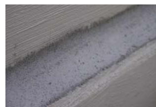
Holle plint met KÖSTER Reparatie-mortel WU
