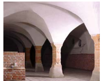
Het metselwerk van deze gebouwen werd hersteld met KÖSTER witte Saneermortel
